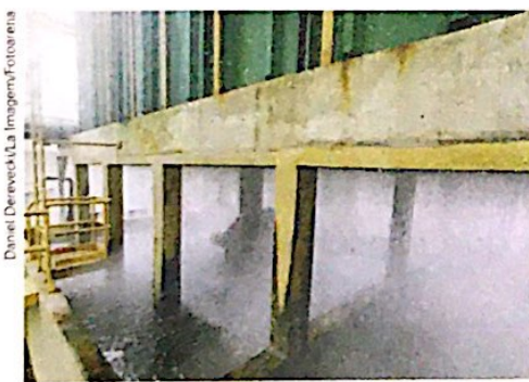
➤ Resfriador industrial em Araucária, no estado do Paraná. Foto de 2015.
