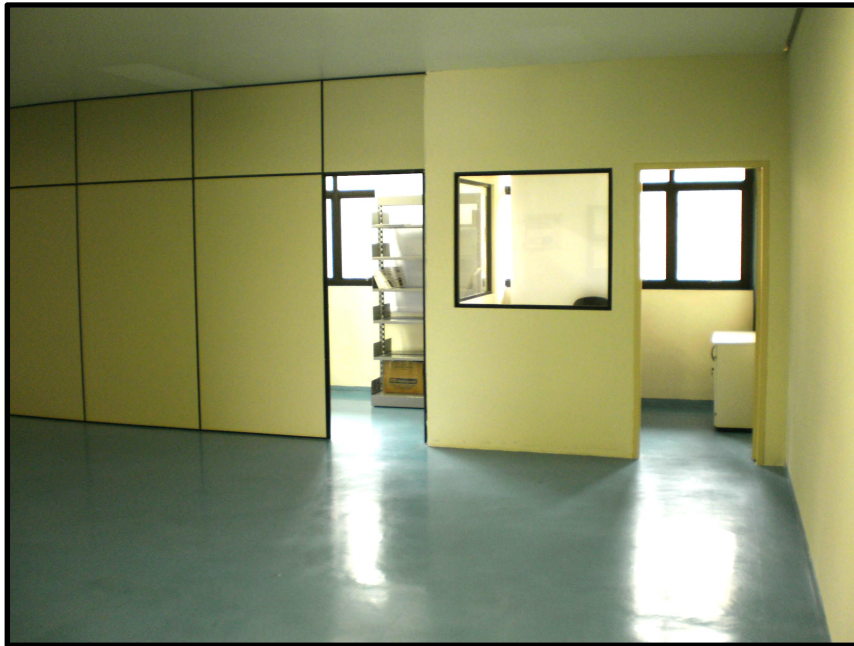
Fotografia 3 - Novas divisórias da biblioteca
