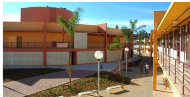
Já concluída a obra do novo Edifício Central, falta finalizar o Campus Guarulhos com Reforma do Antigo Edifício em Arco
