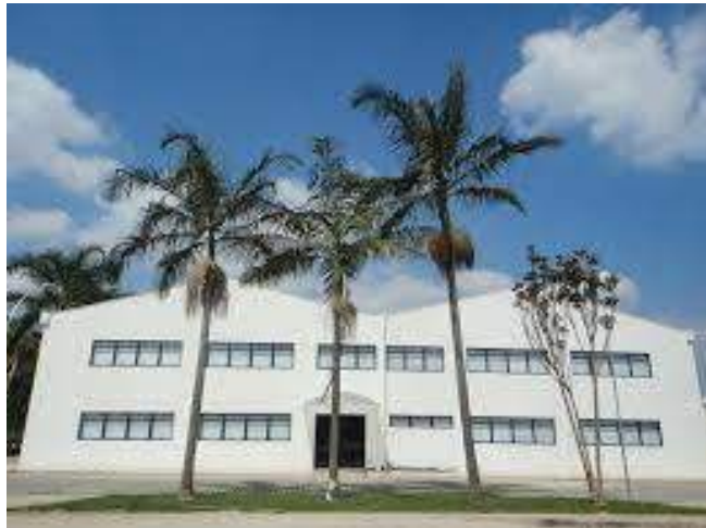
Edificação do Complexo Didático
