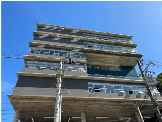
Edificação do Prédio de Acesso
