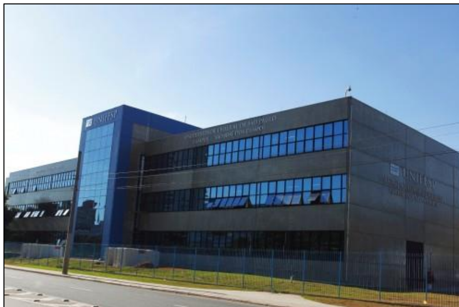
Figura 5 - Novo prédio (unidade) campus São José, inaugurado recentemente. Fonte: http://www.pqtec.org.br/sala-de-impressao/noticias/353/unifesp+anuncia+ampliacao+do+campus+de+s+jose
