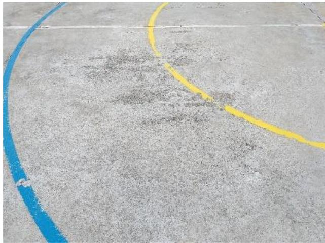
Rachadura e desprendimento de material no piso de concreto polido da quadra.
