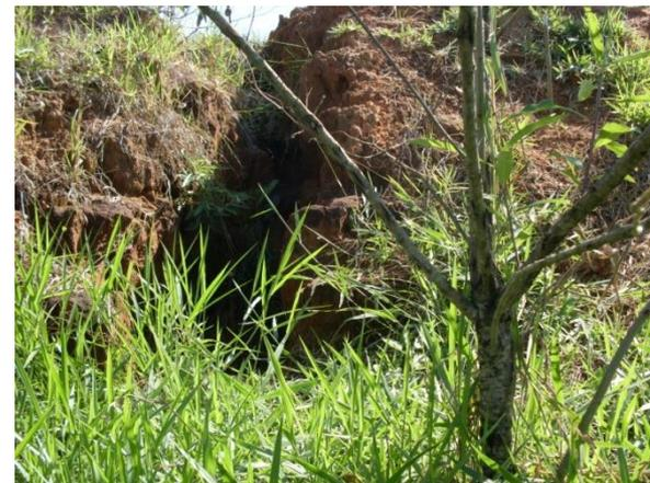
Imagens de pontos de erosão no terreno da Unifesp em áreas que estão contempladas no projeto de terraplenagem licitado. Porém, aparentemente, a execução não corresponde ao projetado.
