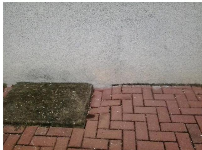
Fotos de alguns dos pontos de afundamento na pavimentação das calçadas.
