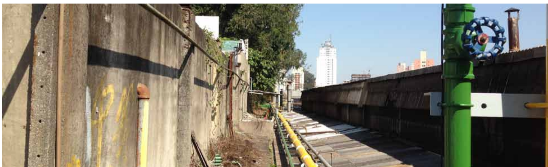
Imagem 2.9: Vista da área reservada para passagem de tubulação da Unforja. Fonte: Idom
