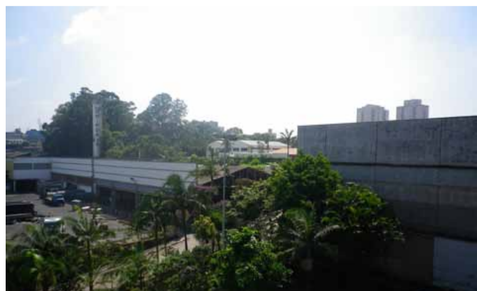
Imagem 2.12: Laminadora da Uniforja vista desde Edifício de Pesquisa da UNIFESP. Fonte: Idom
