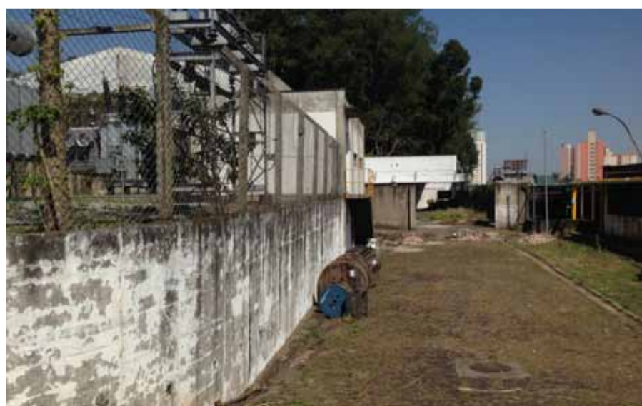
Imagem 2.8: Vista do acesso ao redor da subestação. Fonte: Idom
