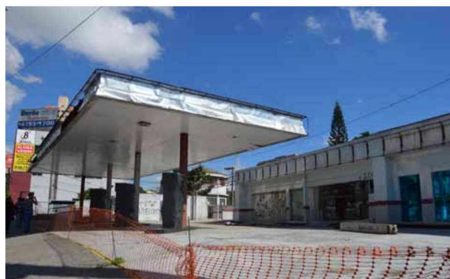
Imagem 2.21: Posto de gasolina desativado. Fonte: Idom
