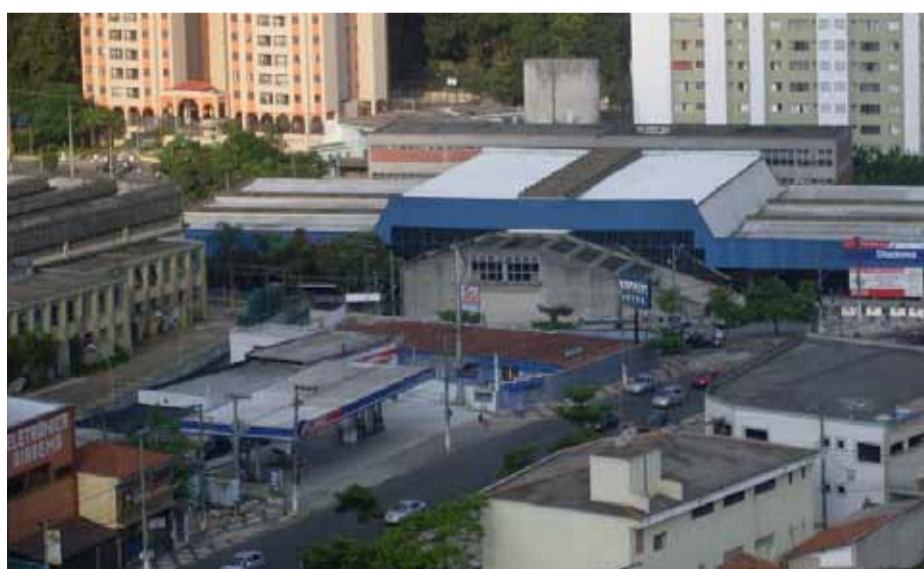
Imagem 2.20: Vista da Av. Presidente Kennedy com posto de gasolina e Terminal ao fundo. Fonte: http://www.panoramio.com/photo/31928747?source=wapi&referrer=kh.google.com
