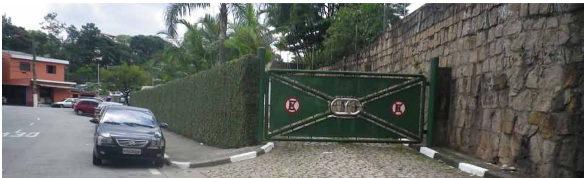
Imagem 2.1: Acesso de veículos da Uniforja, atualmente fechado. Fonte: Idom
