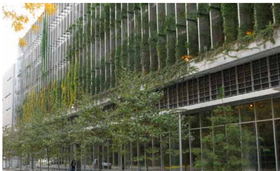
Imagem 1.24: Edifício garagem da Rush University em Chicago. Fonte: http://greenscreenusa.tumblr.com/post/79918266017/rush-university-chicago-greenscreen-r-fins-run
