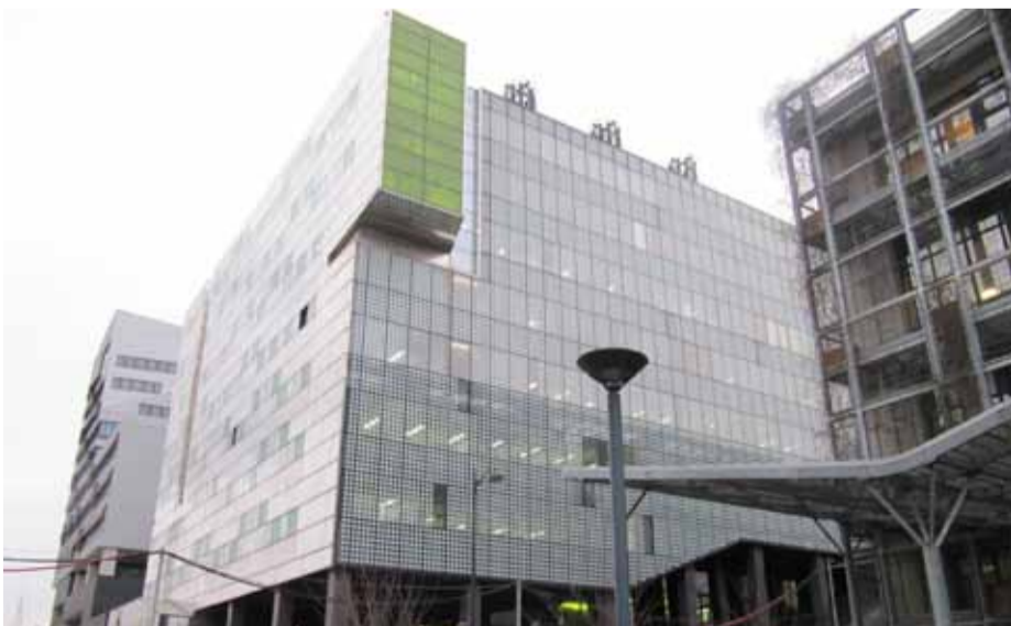
Imagem 1.28: Fachada da Faculdade de Química da Université Paris Diderot. Fonte: Idom
