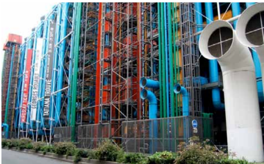
Imagem 1.34: Instalações externas no edifício Georges pompidou em Paris. Fonte: http://www.origindesignstudio.co.uk/blogcrash-course-structural-expressionism/high-tech-architecture.html
