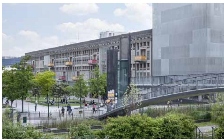
Imagem 1.22: Conexão entre edifícios da Université Paris Diderot. Fonte: http://www.semapa.fr/Maitrise-d-ouvrage-deleguee/Batiments-universitaires-de-Paris-Diderot-Paris-7
