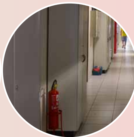
SINALIZAÇÃO TÁTIL E VISUAL
