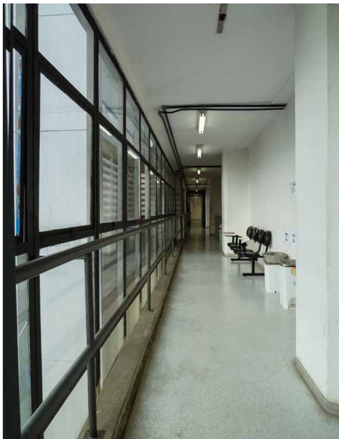
Imagem 5.4.7: Área de circulação do 2º pav. Manoel da Nóbrega Fonte: Idom
