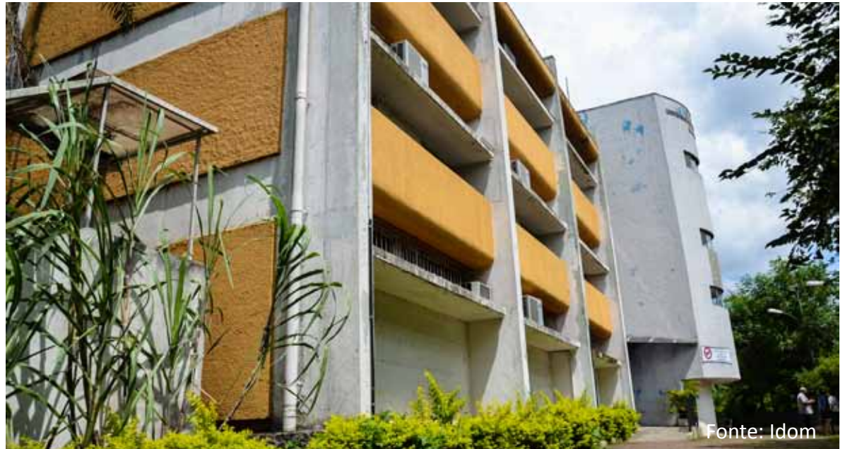
Imagem 5.3.1: Edifício dos Laboratórios de Graduação visto desde a entrada Fonte: Idom
