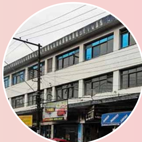
PROBLEMAS DE SINALIZAÇÃO DO EDIFÍCIO
