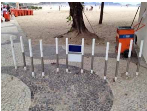
Imagem 9.36: Suporte que dificulta o travamento das bicicletas; Fonte: ACBC, 2013.
