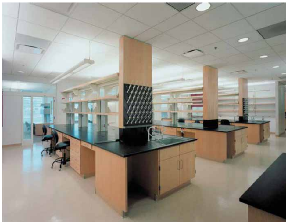
Figura 3.73: Instalação típica de luminárias com iluminação direta/indireta no Donald Danforth Plant Science Center (St Louis, EUA). Fonte: U.S. EPA.
