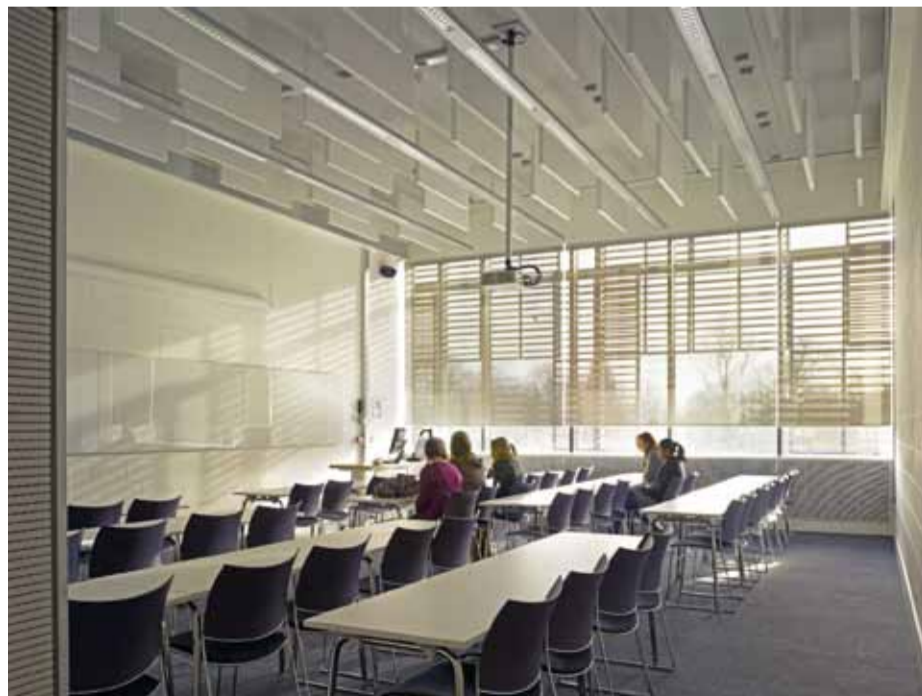
Figura 3.96: Edifício de Ensino St. Alphege / Design Engine Architects Ltd - elementos de proteção acústica em salas de aula. Fonte: Archdaily / Courtesy of Design Engine Architects
