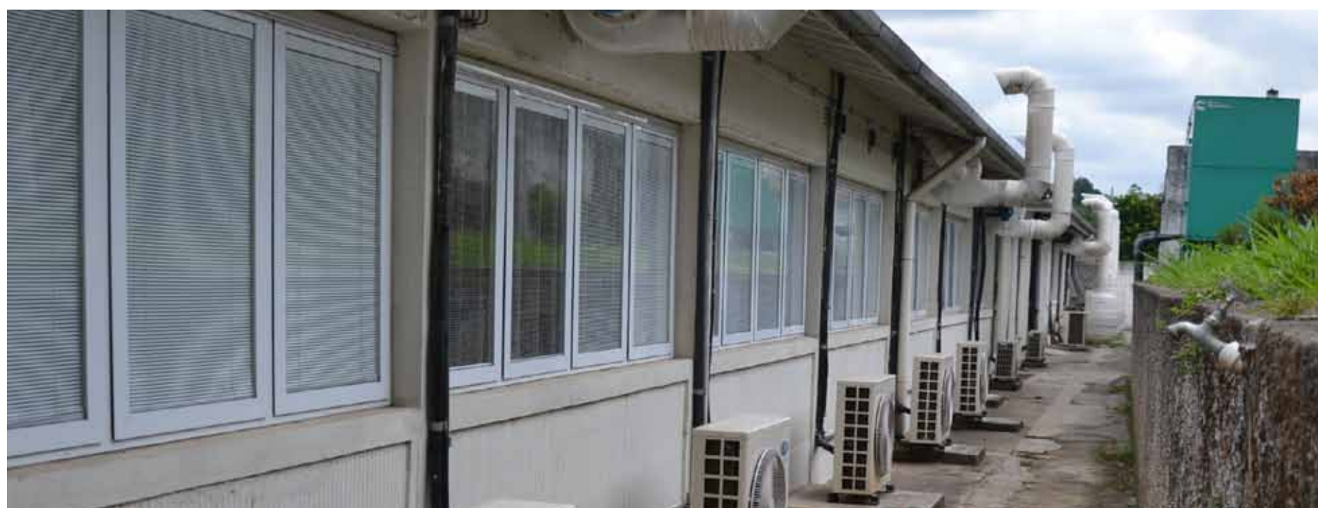
Figura 2.34: Edifício dos laboratórios de Pesquisa Fonte: IDOM
