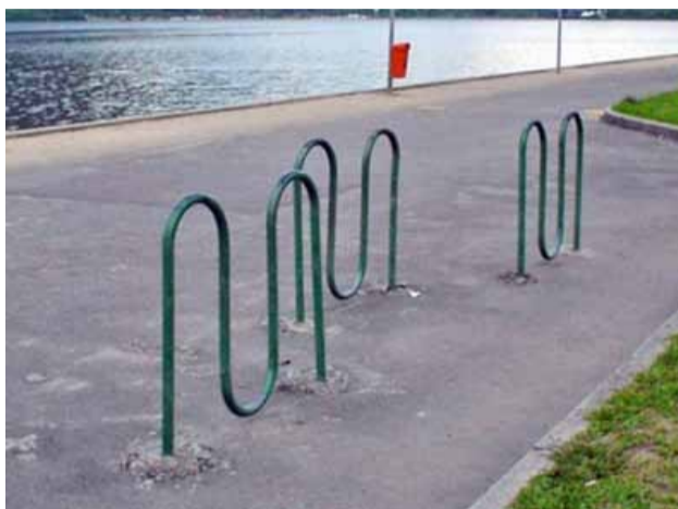
Imagem 9.35: Suporte que dificulta o travamento das bicicletas; Fonte: ACBC, 2013.
