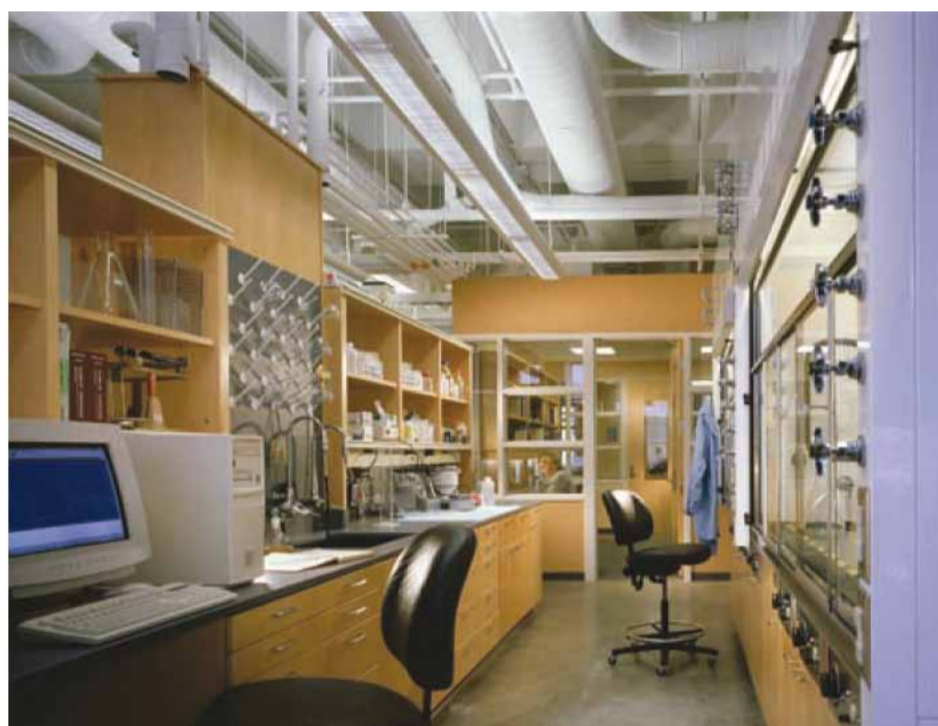
Figura 3.74: Instalação típica de luminárias T8 com iluminação direta/indireta, University of Wisconsin Chemistry Building (EUA). O exemplo mostra que a iluminação indireta pode ser implementada mesmo em locais sem forro. Fonte: U.S. EPA.
