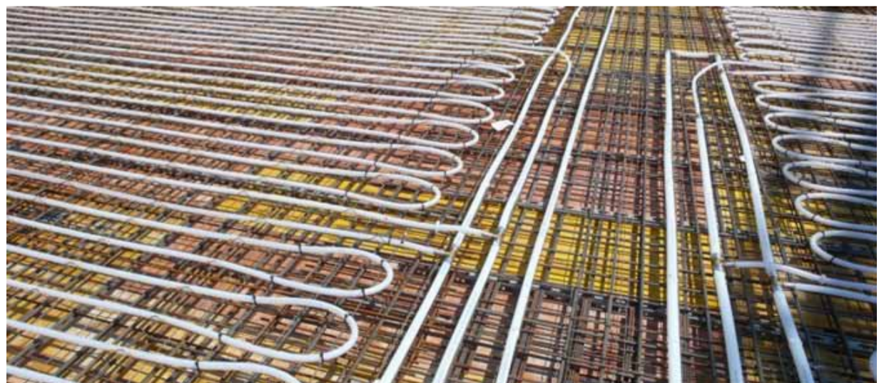
Figura 3.56: Foto de instalação do TABS durante a construção de um edifício. Fonte: www.uponor.com.br
