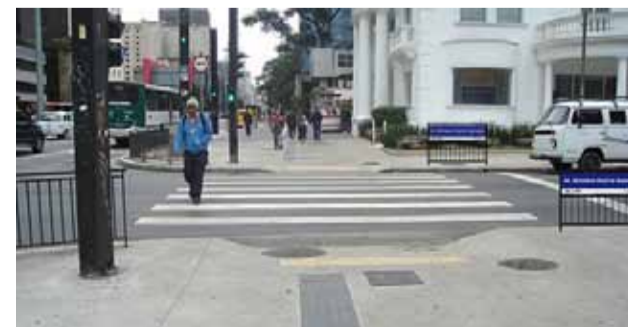
Imagem 9.2: Rebaixamento de calçadas; Fonte: Prefeitura de São Paulo, 2012.
