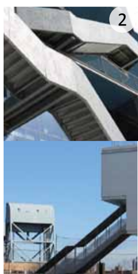
Elem. de proteção solar vertical
