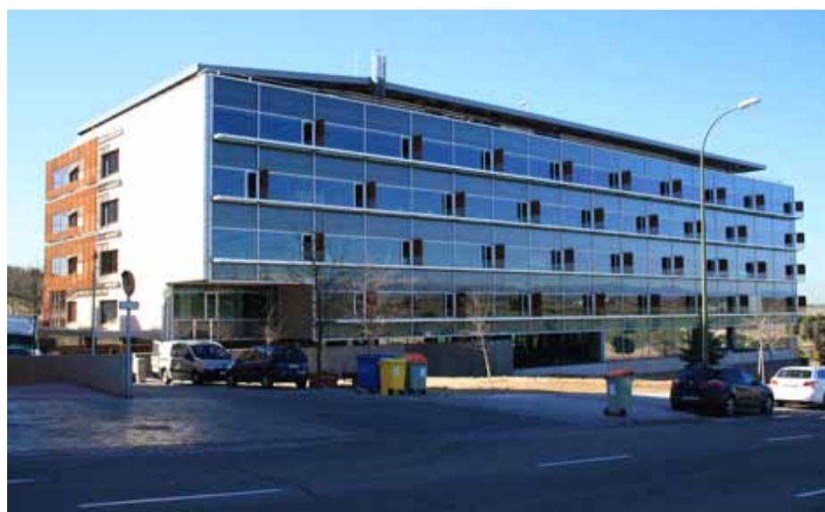
Figura 3.45: Edifício Idom Madrid - elementos de proteção vertical na fachada sul, proteção contra ofuscamento do sol. Fonte: Idom
