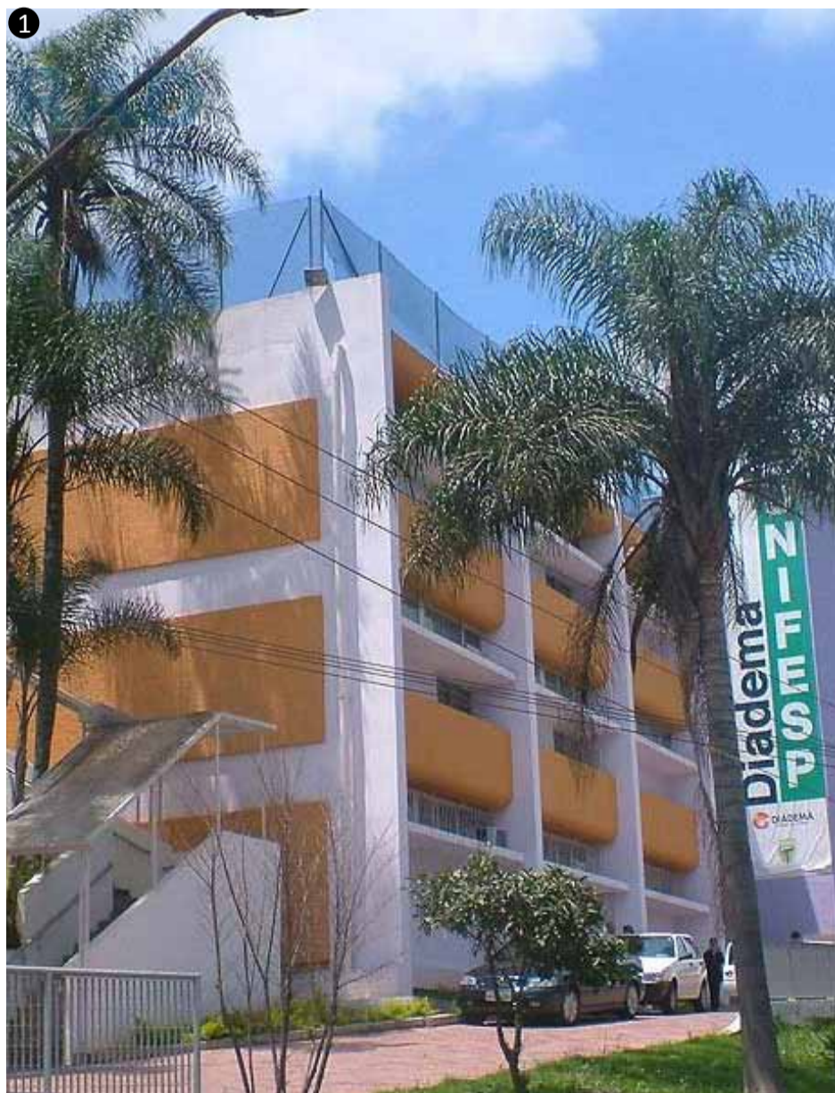
Imagem 6.2: Fotos edifício. Fonte: Panoramio Salles Ribeiro.
