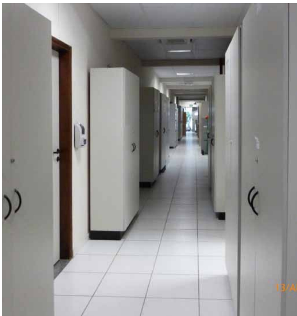
Figura 5.15: Corredores estreitos de circulação e escoamento de pessoas dos corredores na Unidade José de Filippi
