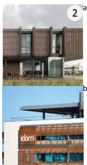
Elem. de proteção solar vertical
