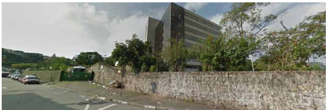
Imagem 9.12: Calçada da Rua Lídia Blank fonte: IDOM, 2014
