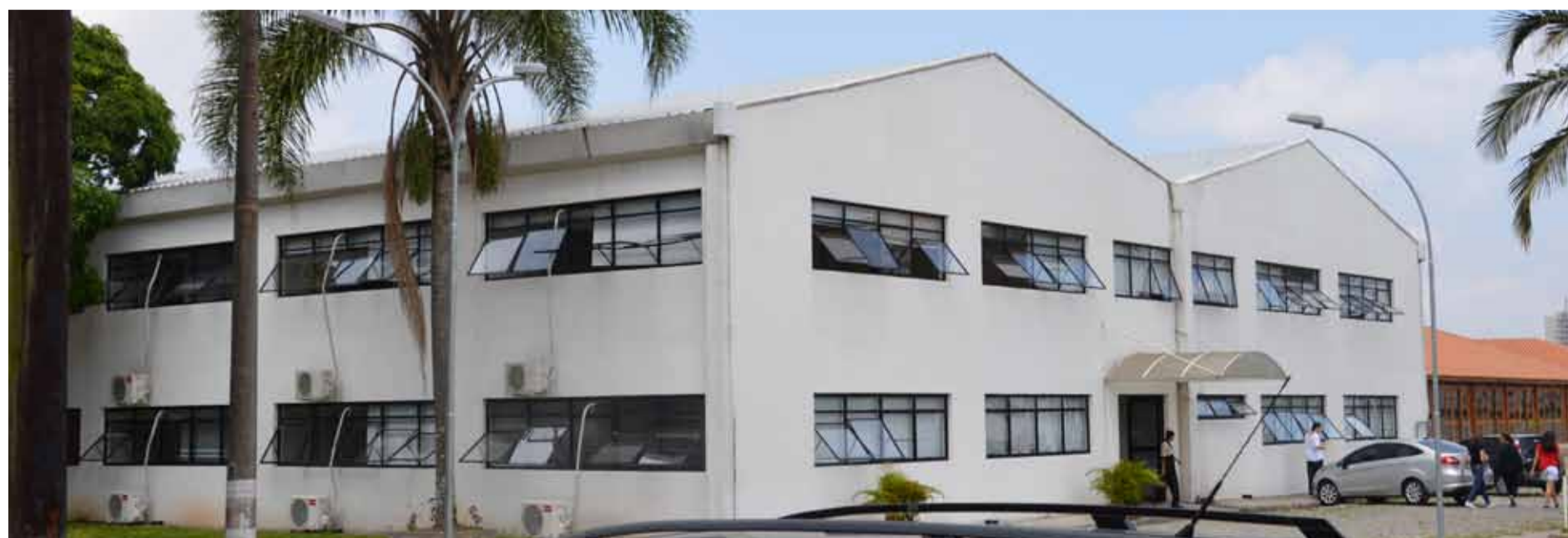
Figura 2.31: Foto da fachada do edifício Didático Fonte: IDOM
