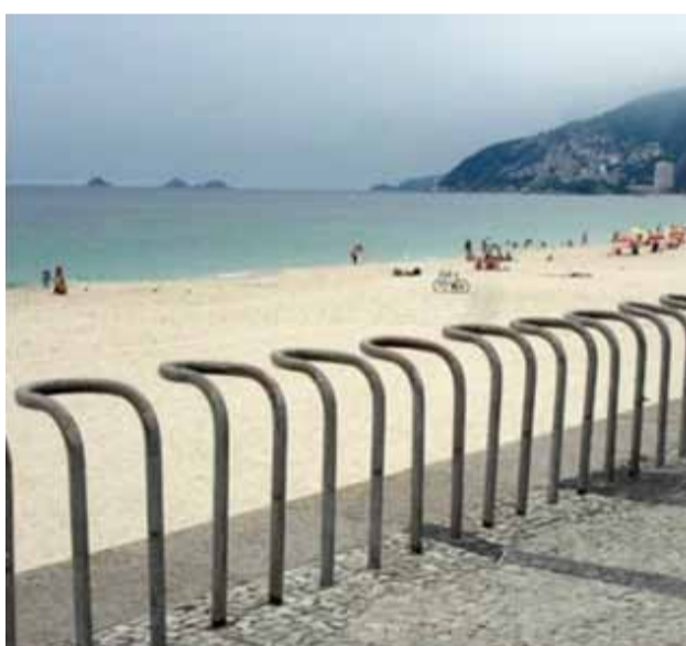
Imagem 9.37: Suporte que dificulta o travamento das bicicletas; Fonte: ACBC, 2013.
